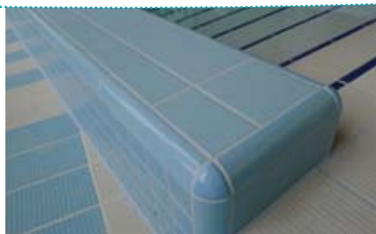
◆ OBŁĘ NAROŻA ELIMINUJĄCE OSTRE I NIEBEZPIECZNE KANTY, NOWY SĄCZ
